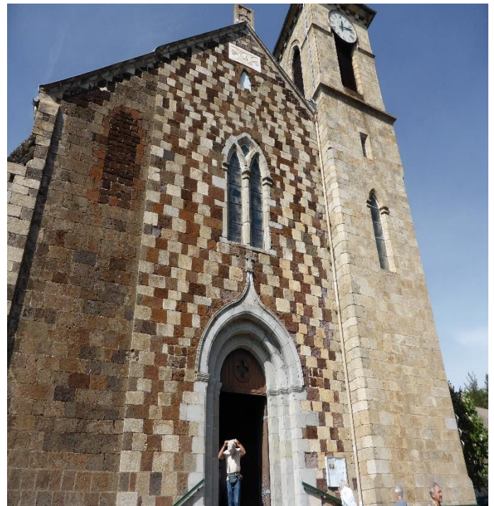
Figure 33. Le damier de la façade de l'église de Borée est constitué de basalte gris, d'arkose et de granite beiges et de tuf à chabasite, de couleur lie de vin (photo D. Géliot).
