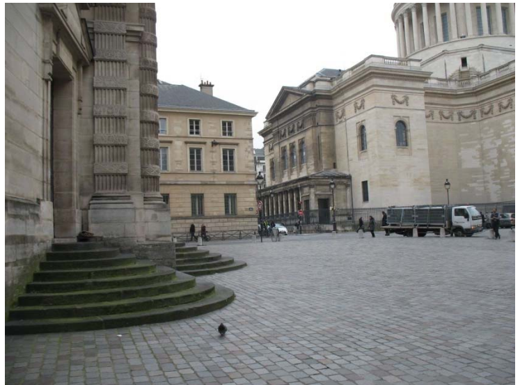
Figure 8. Place Sainte-Geneviève, entre l'église Sainte-Geneviève-du-Mont et le Panthéon : les escaliers de l'église sont en pierre de Volvic (trachy-andésite) et le parvis en pavés disparates.
