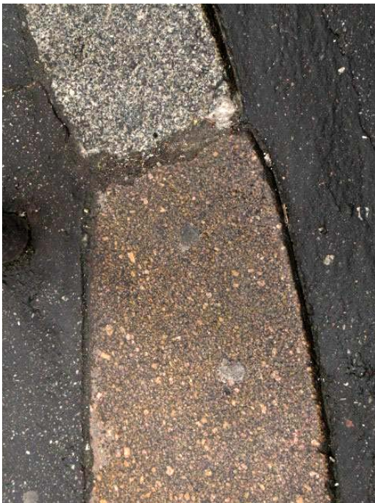
Figure 7. Bordures de trottoir de la rue Cujas, deux granites de Normandie côte à côte, Vire (gris) et Flamanville.
