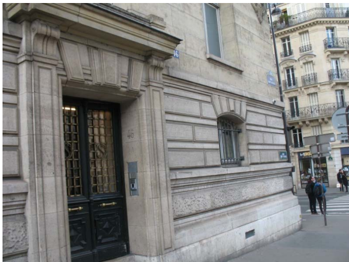
Figure 10. La Sorbonne, au 46 rue Saint-Jacques : pierre de Souppes à la base, au-dessus pierre d'Euville, puis pierre de Savonnières.
