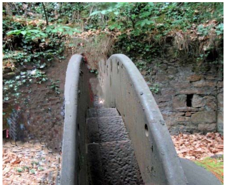
Figure 10. Énorme ventilateur de la machine à vapeur.
