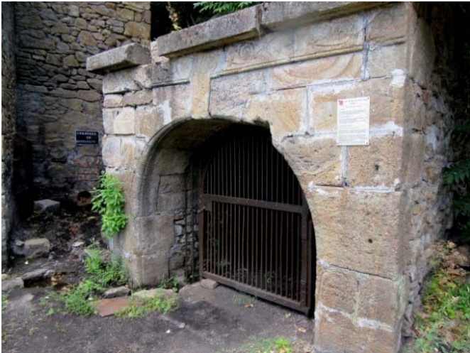
Figure 11. Entrée de la mine.
