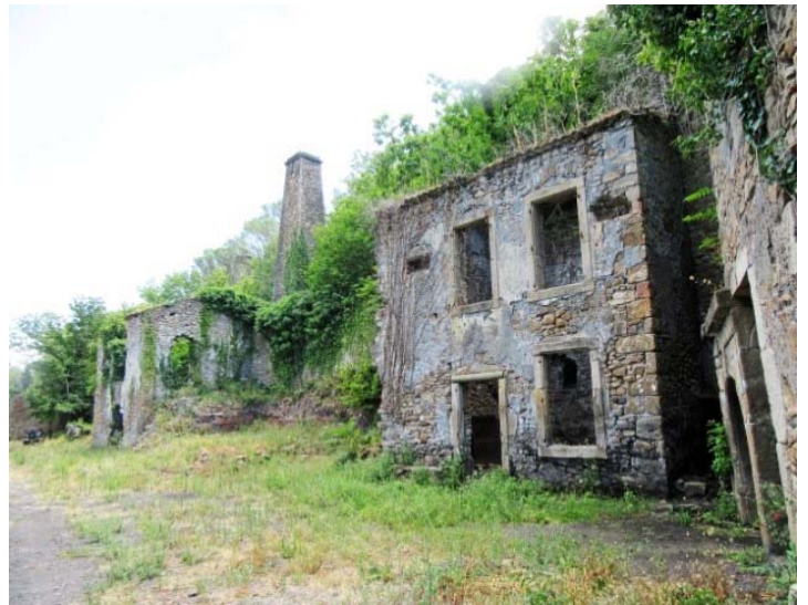
Figure 9. Bâtiments de l'ancienne mine Simon supérieur.
