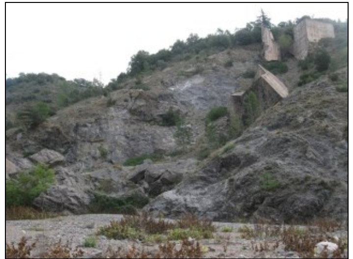
Figure 16. En rive gauche : le dièdre rocheux emporté avec le barrage.
