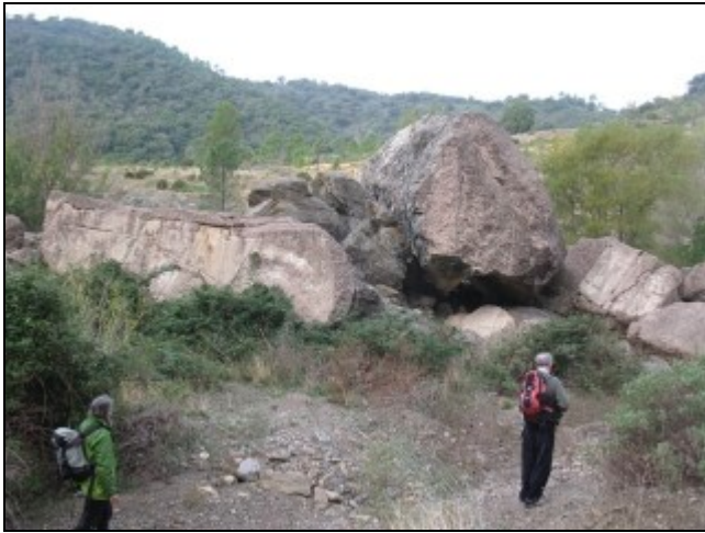
Figure 17. Dans la vallée du Reyran, en aval, blocs du barrage emportés par la catastrophe.
