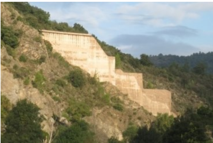
Figure 15. Barrage de Malpasset. En rive droite, ce qui reste du barrage ancré sur son substrat.
